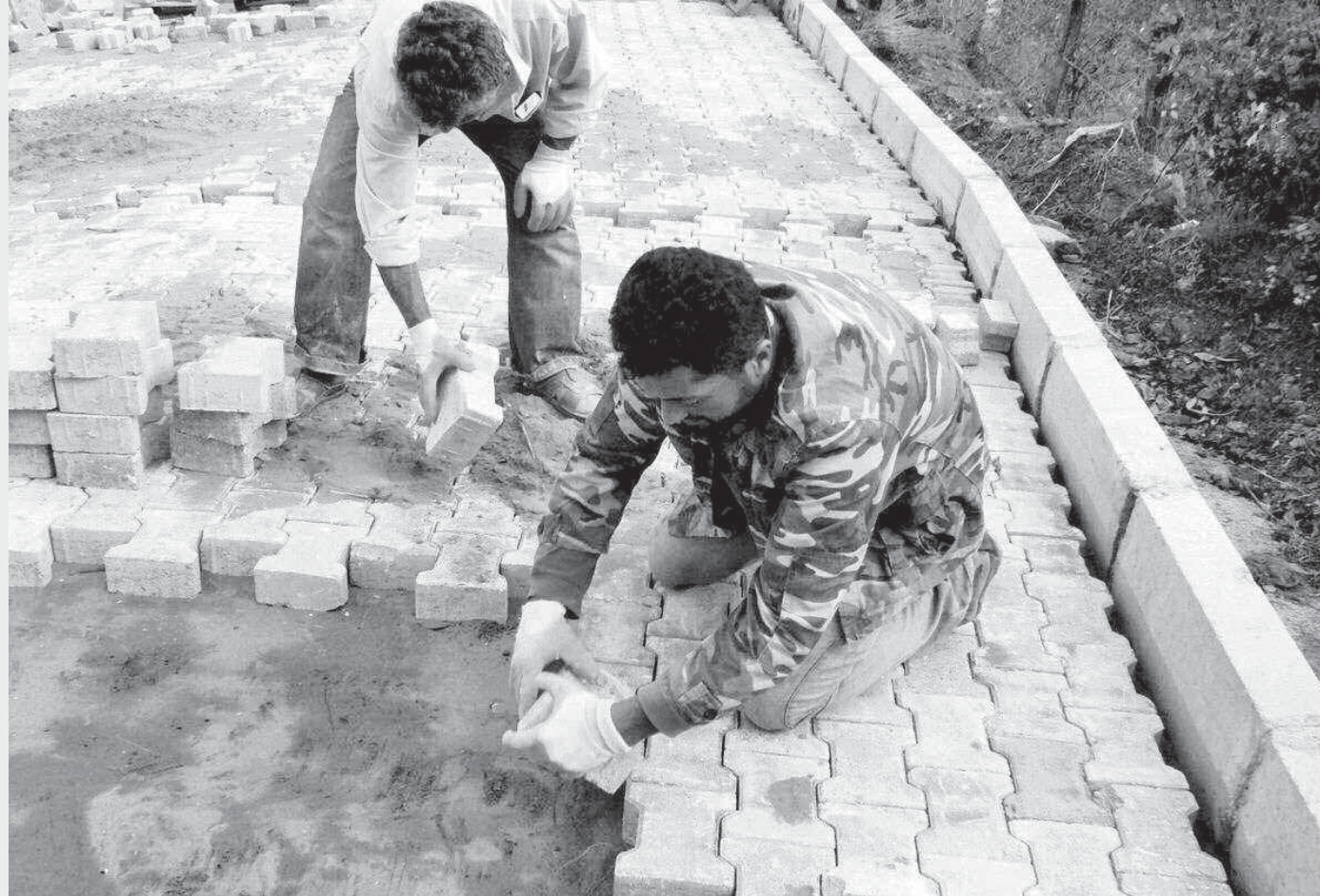
Aydın Belediyesi'nde parke döşeme işinde çalışacak 35 işçinin ismi, noter huzurunda kura çekilerek belirlendi.
