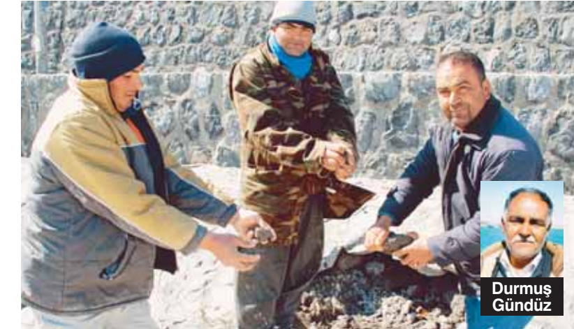
Balıkçılar barınaktaki betonun yetersiz olduğunu, taşların döküldüğünü belirtiyor.
