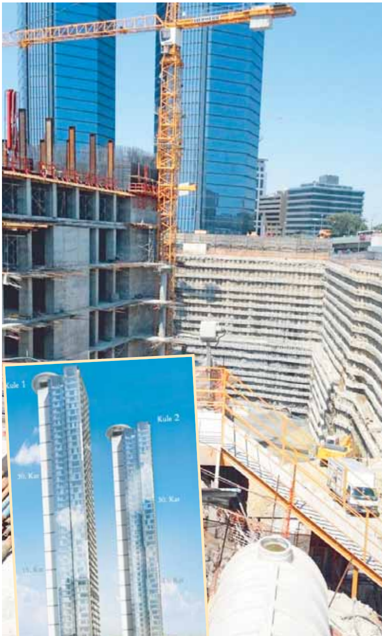
Bodrum katlar emsale dahil edilmeyerek yapımcı firmaya kıyak geçilmiş.
