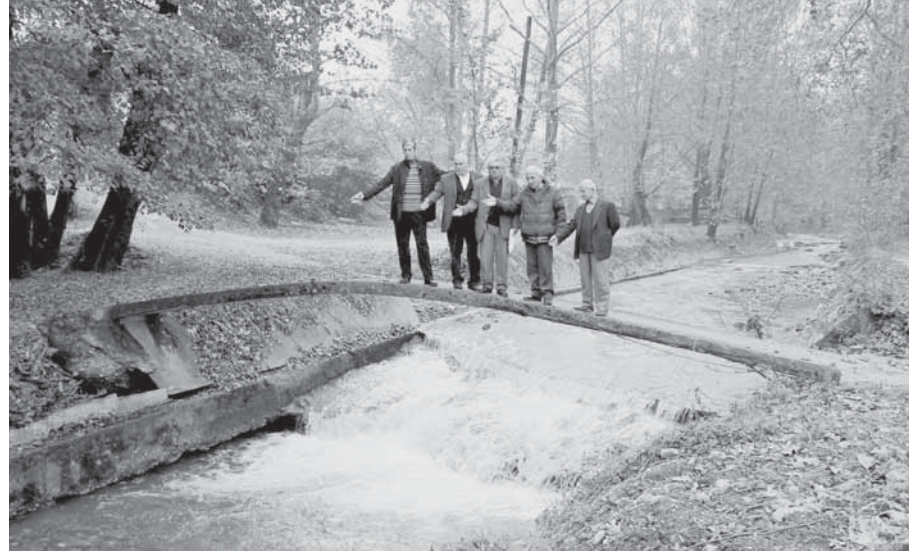
Bıçkı deresinin suyu otele kiralandıktan sonra ormandan dereye boru hattı döşendi.
