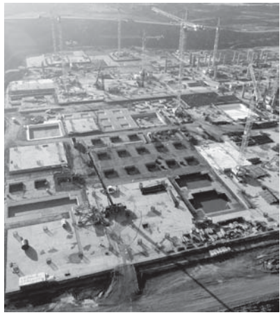
İstanbul'un kuzeyinde yapımı devam eden 3. havalimanı inşaatı sürüyor.
