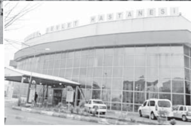
Cizre Devlet Hastanesi, PKK tarafından bombalandıktan sonra hasarlı durumda.
