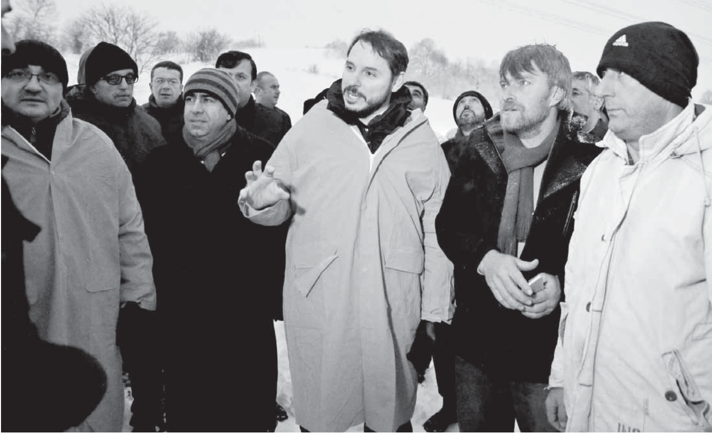
Bakan Albayrak, yılın son gününde Kocaeli’nin Körfez ilçesi Sevindik Mahallesi’nde İstanbul, Kocaeli ve Sakarya’da elektrik kesintilerine neden olan arızanın giderilmesi için yüksek gerilim hatlarında çalışan ekipleri ziyaret etmiştir.
