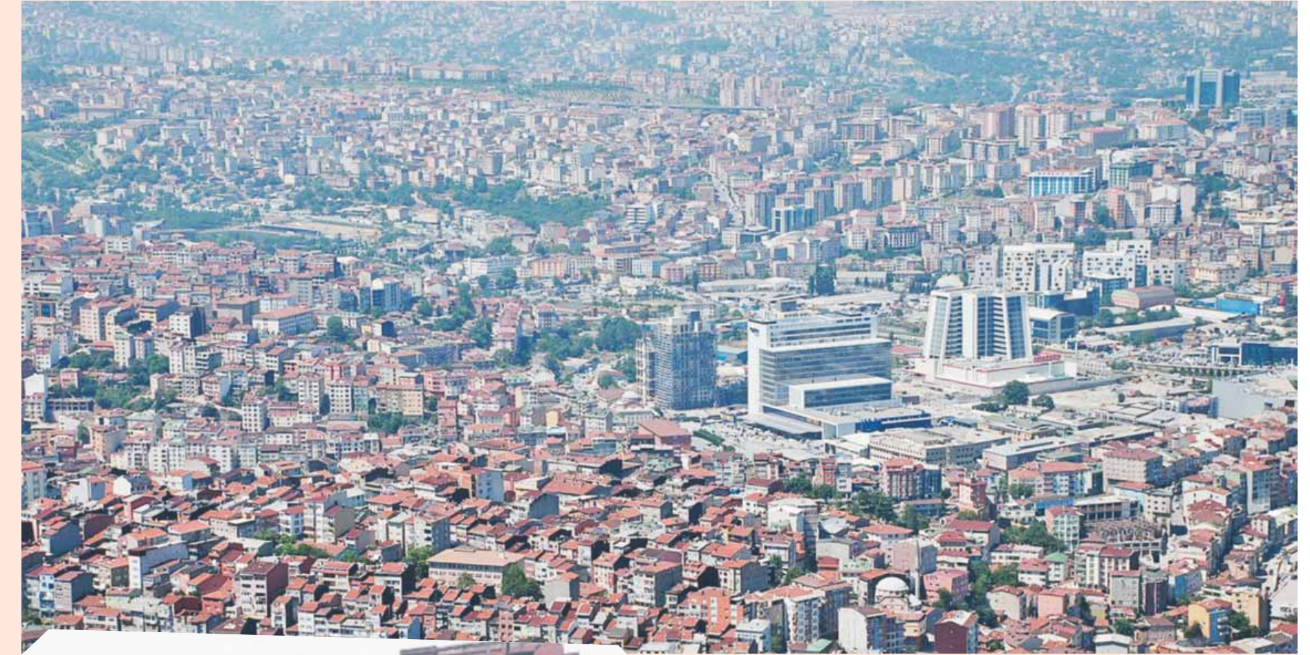
Geçen yıl Rize'de meydana gelen sel nedeniyle dere yatağına yapıldığı öğrenilen bina tartışma yaratmıştı.
