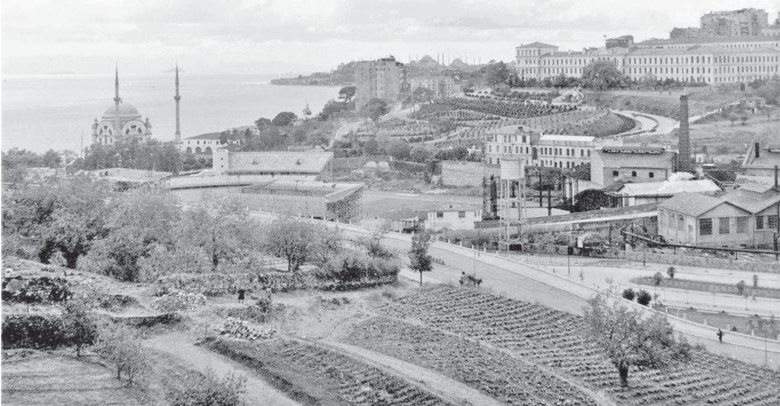
Dolmabahçe İnönü Stadi yapım günleri.
